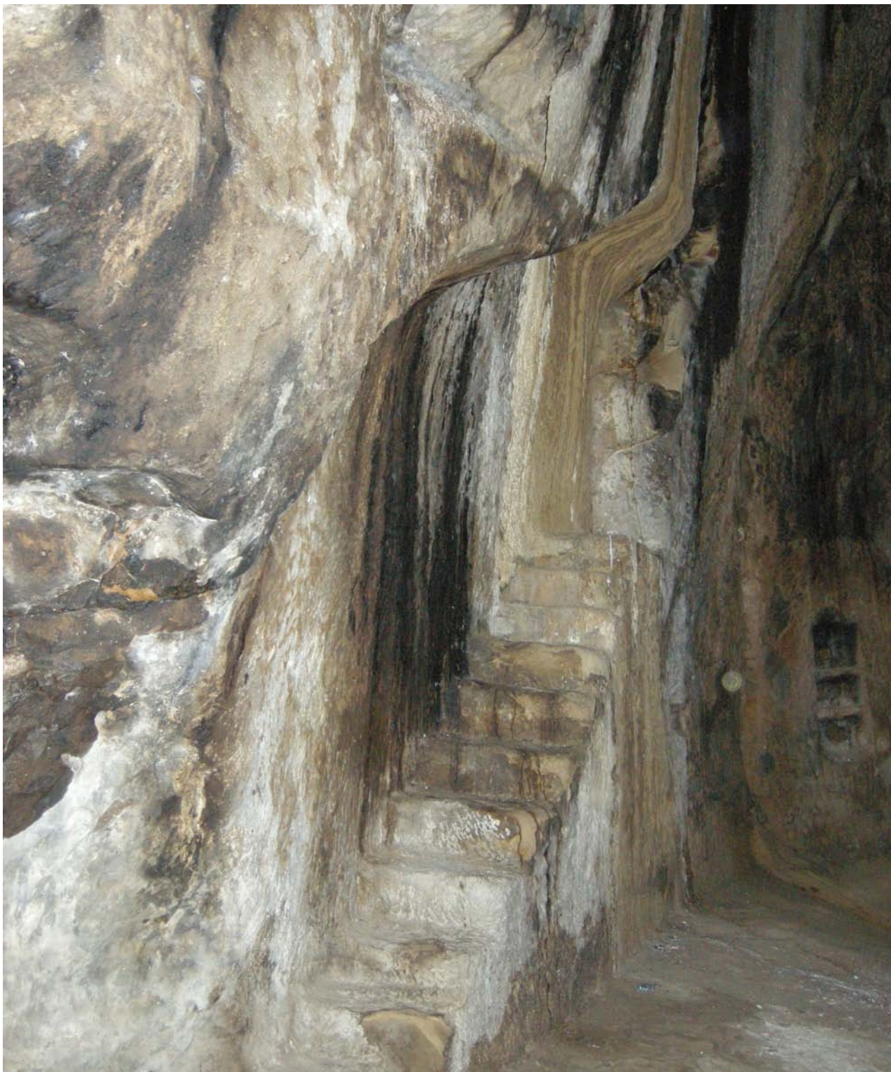
Fig. 31 Scala ricavata nella roccia all'interno del vano a campana, ampliando la parete originaria
