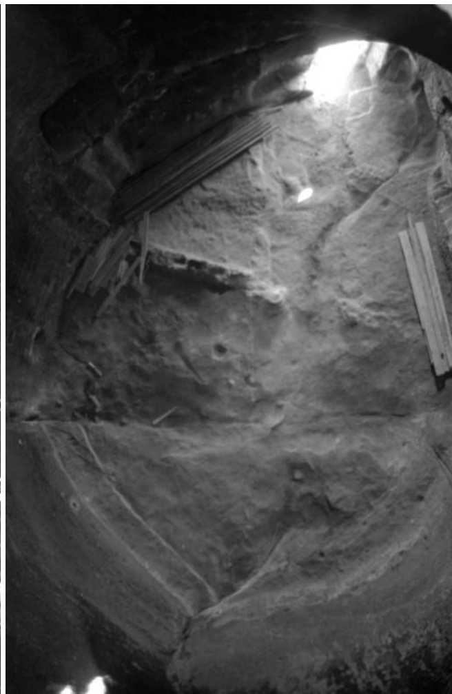
Fig. 9 L'ambiente "a campana". Veduta dall'oculo centrale, si noti l'elemento di suddivisione dell'ambiente (foto R. Salerno)
