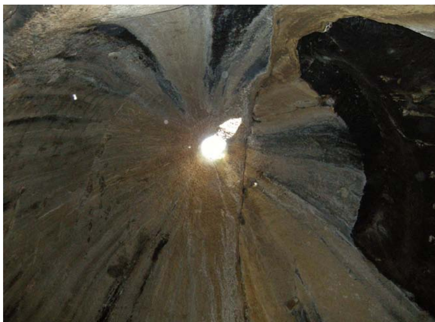
Fig. 22 La volta del vano a campana con foro superiore
