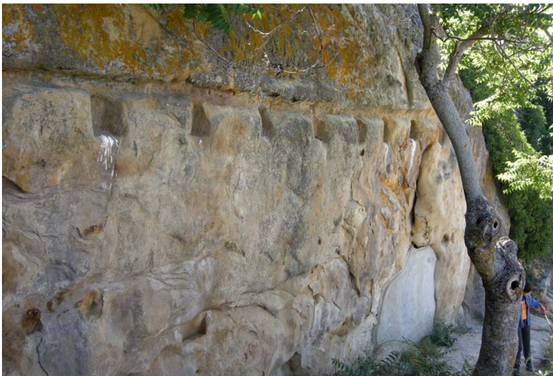
Fig. 20 Tracce di fori per le travi lignee relative ai tetti dei caseggiati realizzati all'esterno della parete rocciosa della Gurfa
