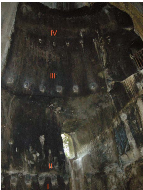
Fig. 32 Parete meridionale del vano a campana con l'ampliamento della fase C e i diversi piani definiti dai fori per le travi lignee delle solette
